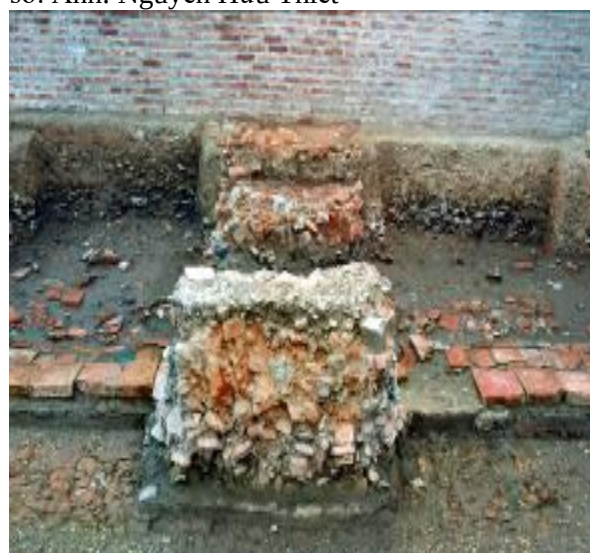
Hình 16: Móng cột kiến trúc thời Lê Trung hưng tại khu A 18 Hoàng Diệu. Ảnh: Phạm Văn Triệu
