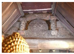
3. Cấu trúc bộ vì chùa Thái Lạc, Hưng Yên.
